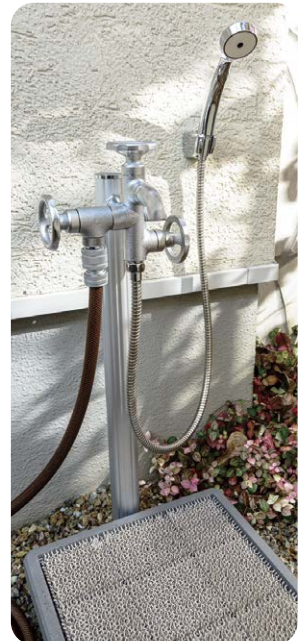
「三口横水栓ウォーターワークス(メッキ)」と「スクエアG15(グレー)」の施工例
