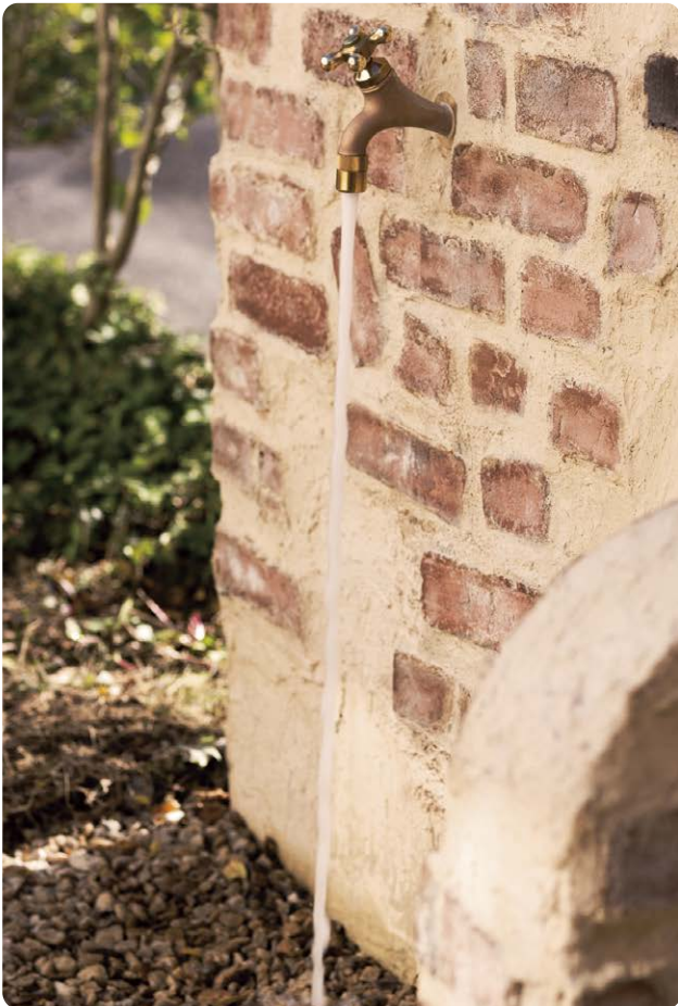
「T14型横水栓(錆肌)」の施工例
