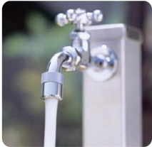
泡沫アダプターの施工例
