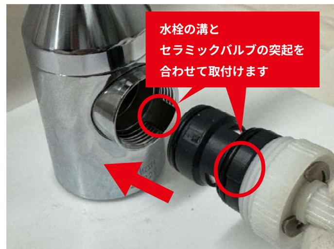
他の部品を元の様に付け直し、止水栓を開いたら完了です！
